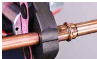
2. Effectuez le sertissage à l'aide de l'outil approuvé. Ne sertir qu'une seule fois
