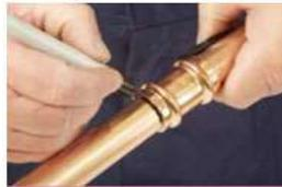
Insérer le tube jusqu'à l'arrêt (butée)
